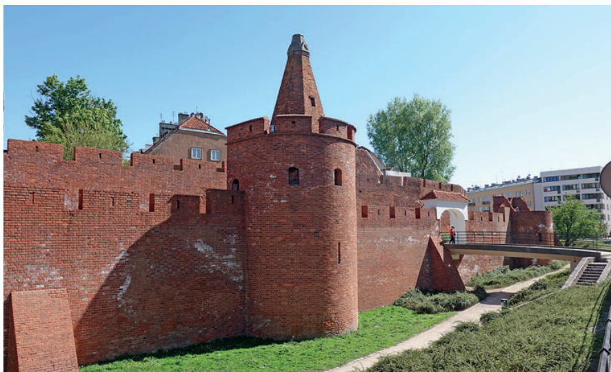
Warszawa, Stare Miasto – mury obronne. Fot. L. Królikowski
