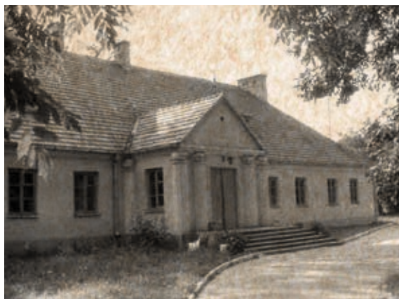
Głusków – dwór. Własność hr. Przebendowskich. Stan obecny.
