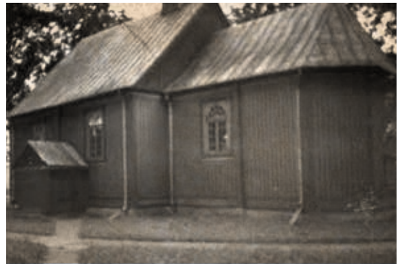
Kościół w Niechłonie, fundacji Kazimierza Rudzińskiego 1757 r. stan obecny.
